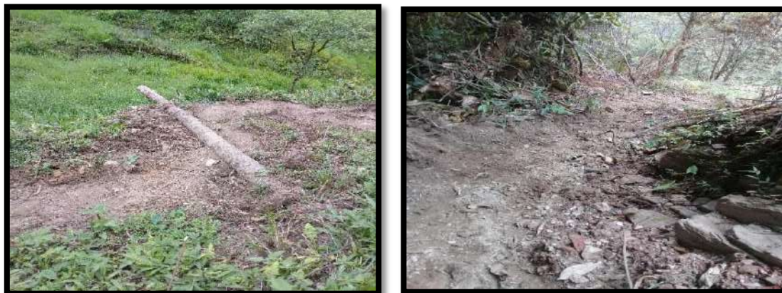
Figura 13. Reparación de caminos Nueva Esperanza
